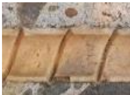
Závit v betonu s vyplněním chemické hmoty
