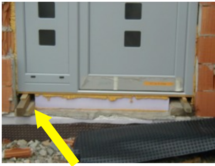
Nepodložená konstrukce dveří
