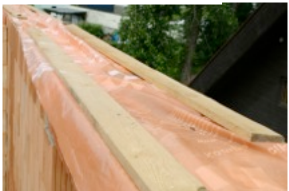
Korunu zdiva chráníme před deštěm a zatékáním vody.
