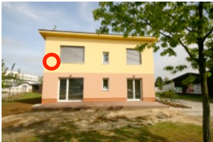
Jižní fasáda 2. NP ložnice
