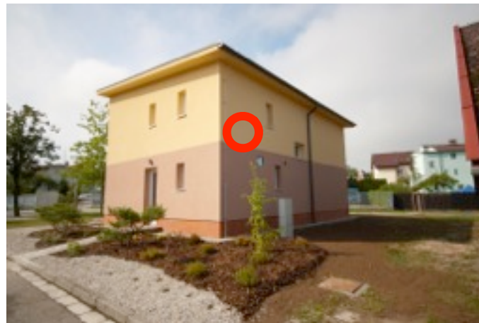
Severní stěna 2. NP pod vanou
