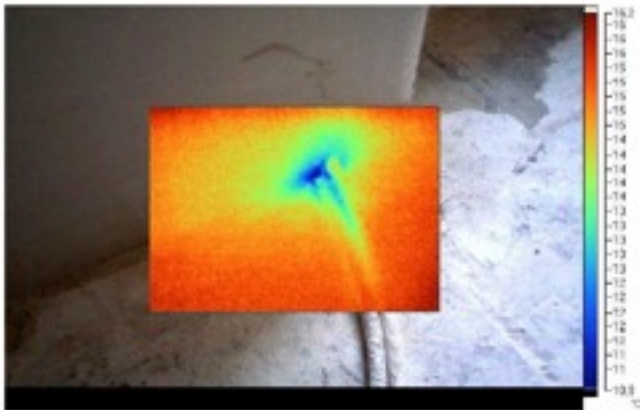
Obr. 18 Proudění vzduchu prostupem elektroinstalací skrz vnitřní omítku
