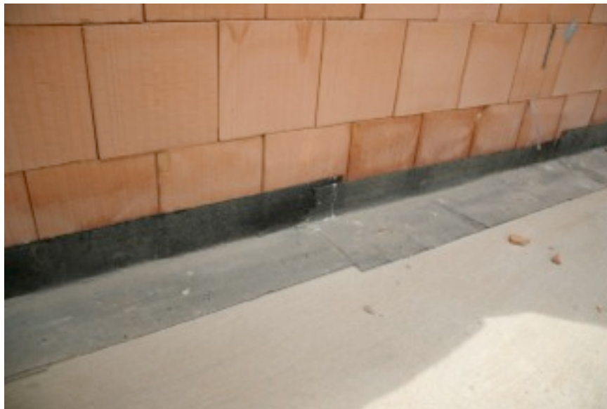
Ochrana paty zdiva před nasáknutím vodou (zhotovení zpětného spoje z asfaltového pásu popř. gumoasfaltu)
