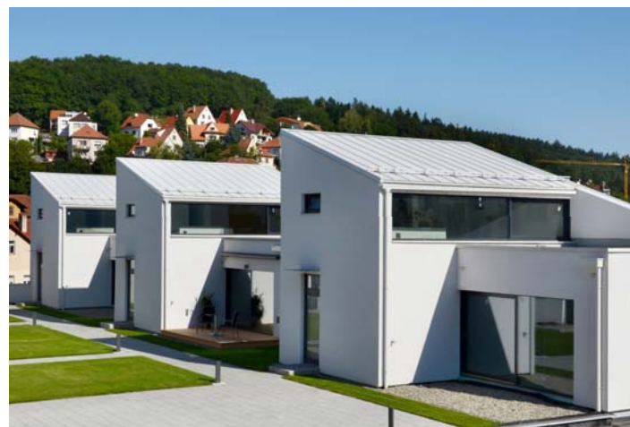
Nástavba, Luhačovice Rodinné domy na střeše obchodního centra
