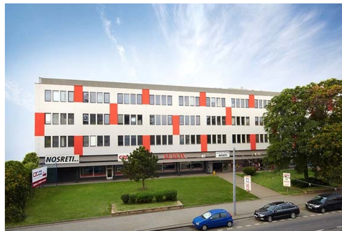
Administrativní budova Brno Rekonstrukce boletických panelů
