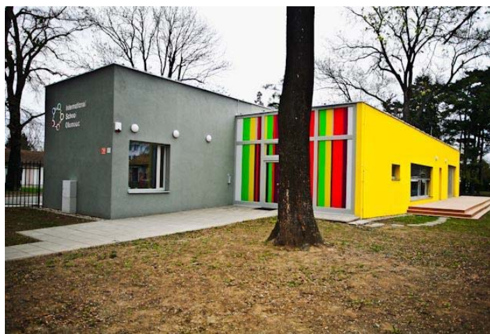
Nízkoenergetická školka, Olomouc dřevostavba
